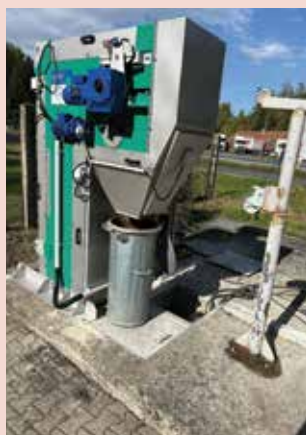
Nově budou nainstalovány česle hrubých nečistot
