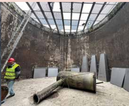
Kontrolní den se stavebním dozorem (foto – dno aktivační nádrže)
