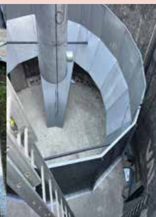
Nová dosazovací nádrž – montáž
