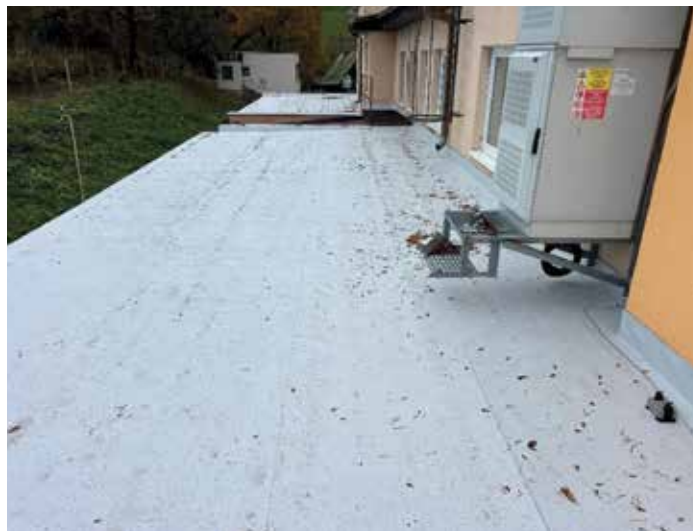
Nová opravená střecha části objektu RS KORD
